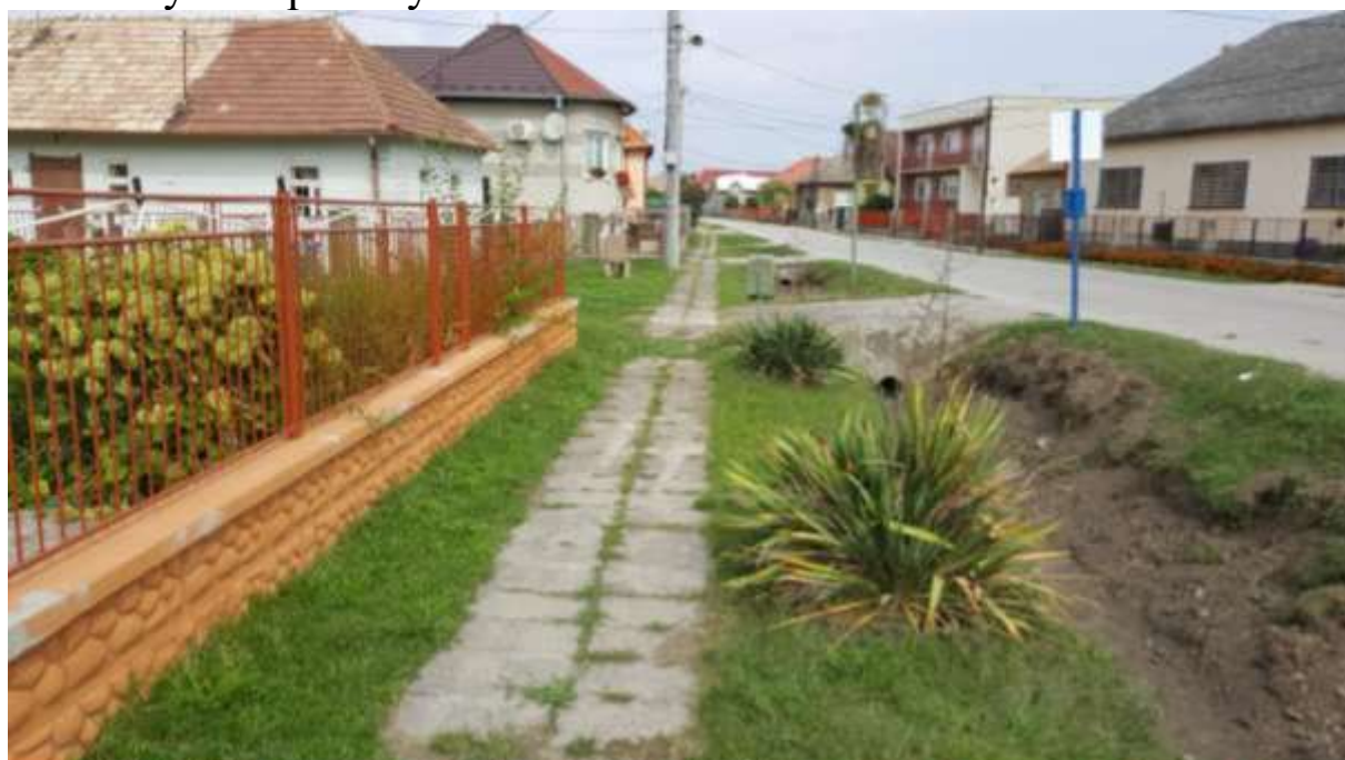
Skutočný stav pred výstavbou
